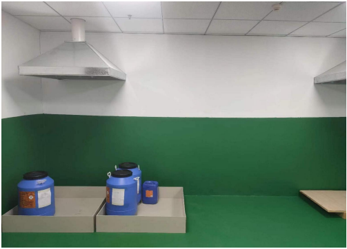
危废间防渗防腐、照明、通风
