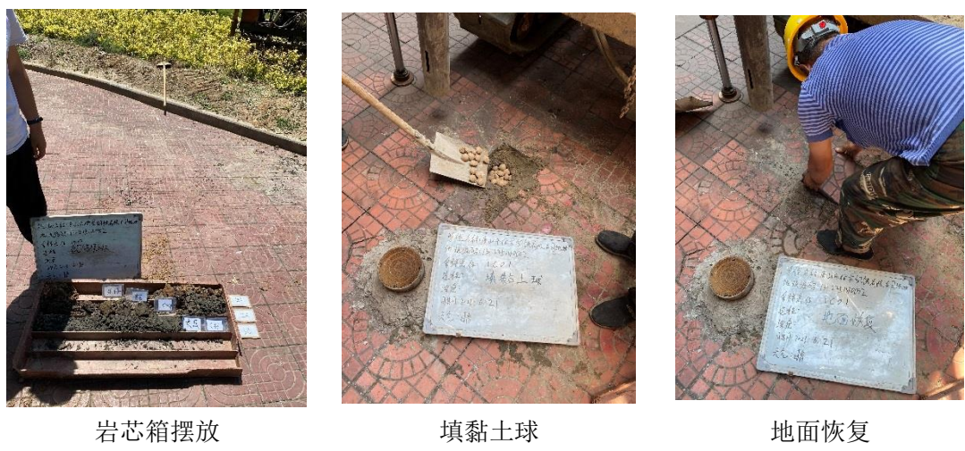
图 5.1-1 土孔钻探与样品采集环节典型影像图
